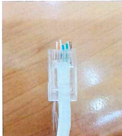
Gambar 2.16 Kabel sebelum diCrimping
